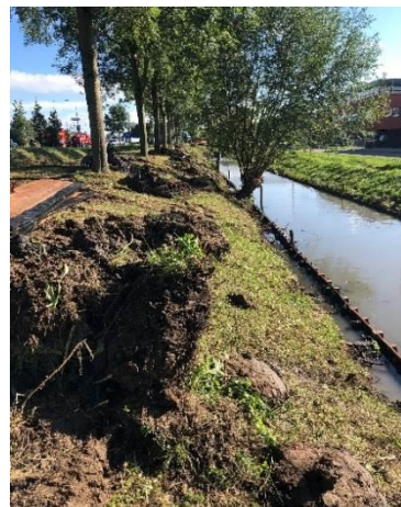
Vervangen schottenbeschoeiing Tinbergenlaan
