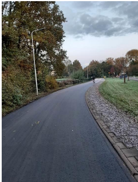
Groot onderhoud asfalt
