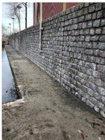
Voegen kademuur IJsselhal
