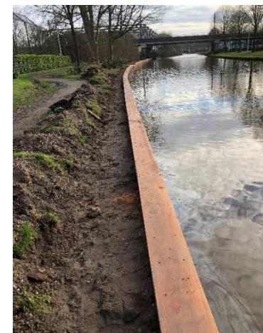
Vervangen damwanden GHIJ Sportpark IJsseloever
