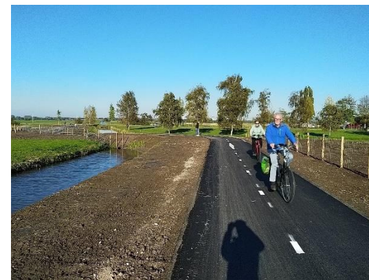
Figuur 4 Het nieuw aangelegde fietspad
