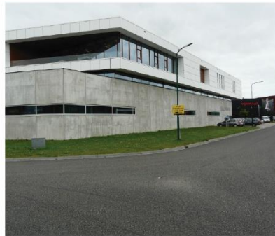
Representatieve zijde bedrijfsbebouwing aan de straat
