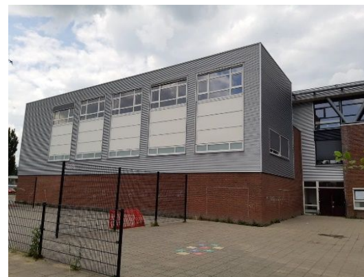
Foto 1: Reiniging gevelbekleding uitgevoerd bij het WOC
