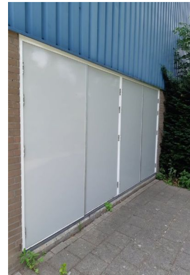
Foto 4: Schilderwerk van de buitendeuren bij sporthal 't Heem
